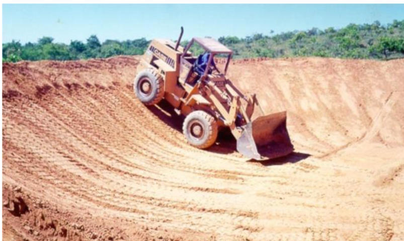
Figura 4- Construção da Barraginhas. Fonte: PEREIRA (2012, p.11)
