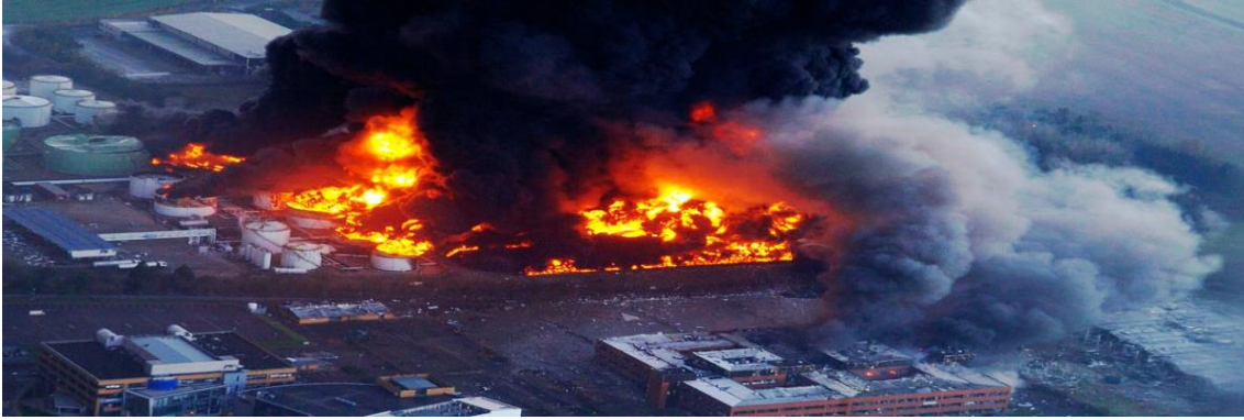
Figura 2: Acidente em Parque de Tanques em Cubatão (Fonte: Petrobras, 2016)
